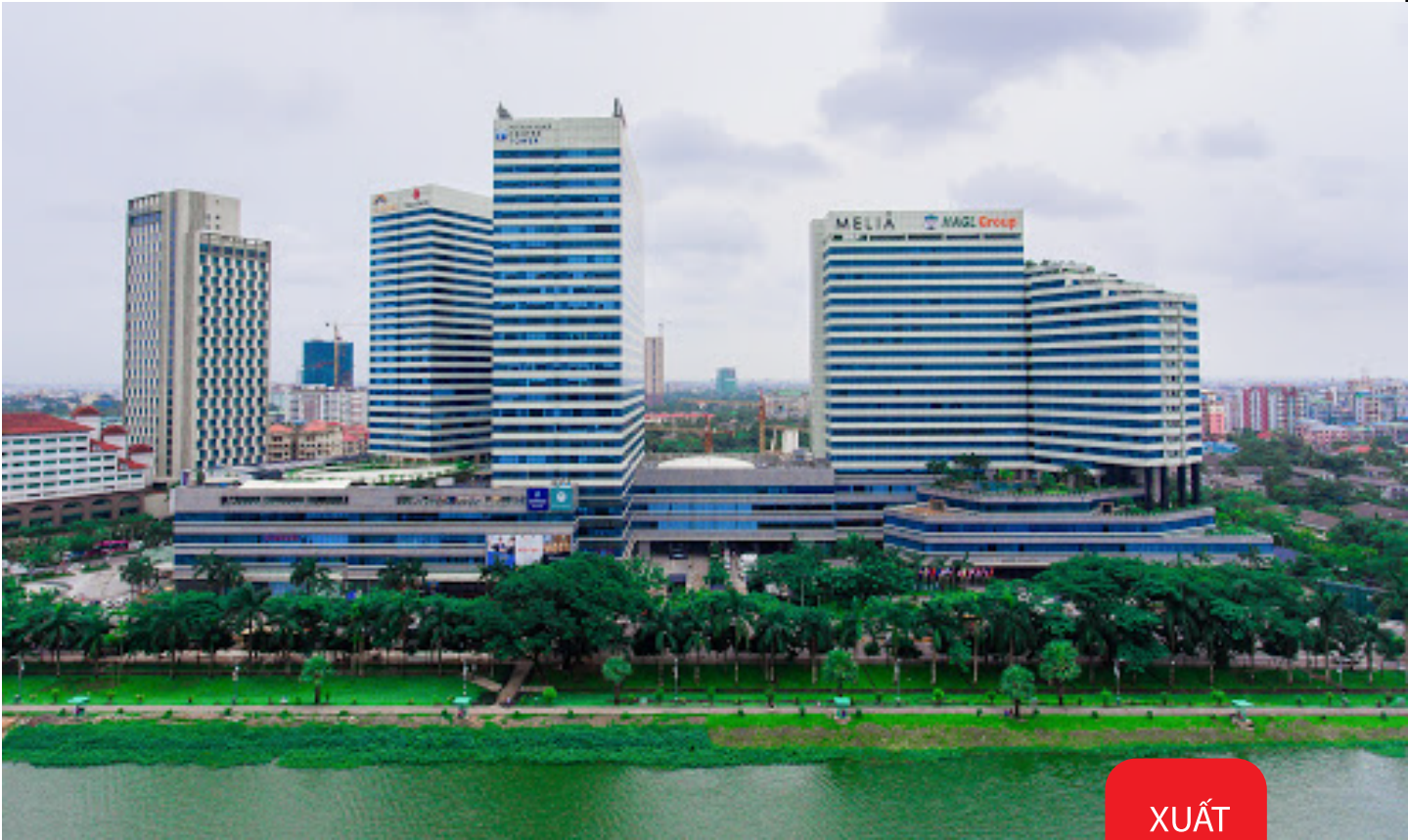
Block B1 Residential Unit of HAGL Myanmar Centre Chủ đầu tư: Tập đoàn Hoàng Anh Gia Lai
