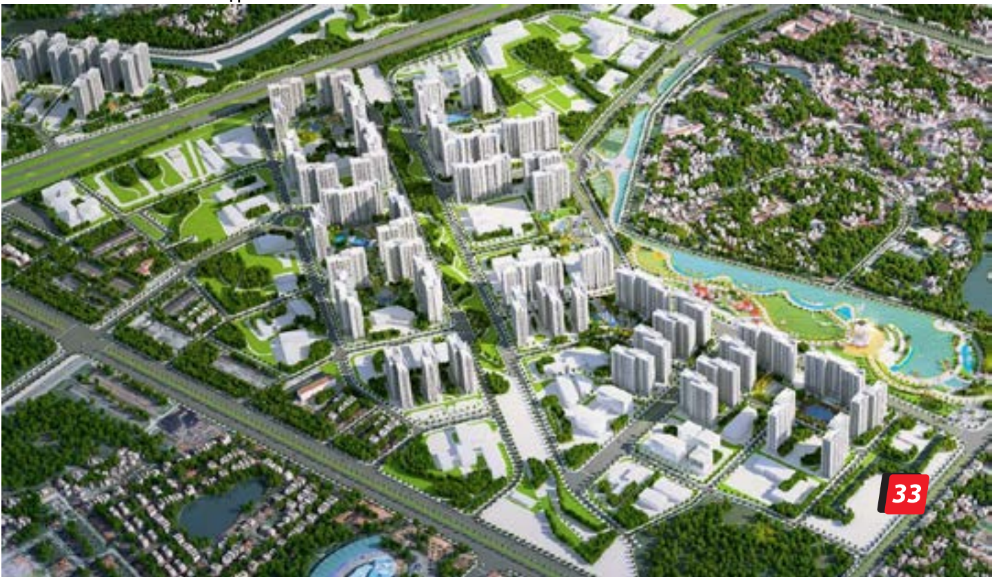
Khu đô thị Vinhomes Smartcity Chủ đầu tư: Tập đoàn Vincom
